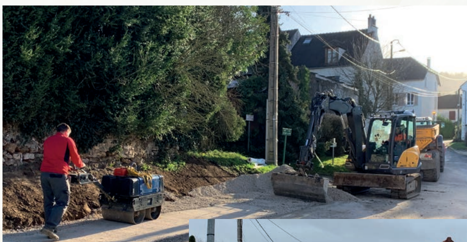
Création de parking Rue du Fief Adam.
