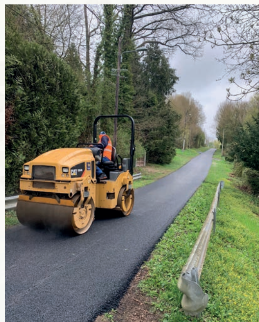
Rénovation du chemin des Pentes.
